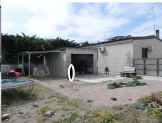
fabbricato deposito con terttoia
