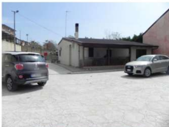
Fabbricato alloggio con porticato
